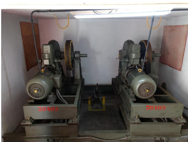
Máquinas de Tração e reguladores de velocidade
