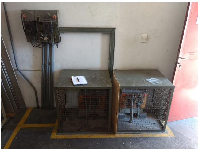
Posicionamento dos transformadores e quadro de disjuntores de entrada
