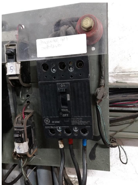
Detalhe do disjuntor de entrada em 380 V – 3Ø – 60 Hz
