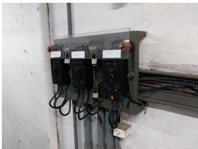
Posicionamento do quadro de disjuntores de entrada
