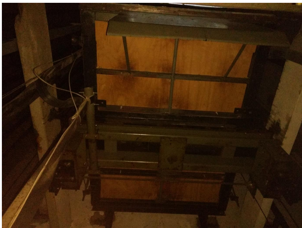
Fundo da cabine de um elevador mostrando o dispositivo de segurança atual
